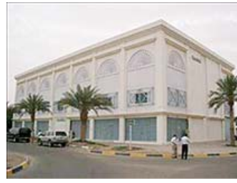
中東の冷房を供給するプラント
