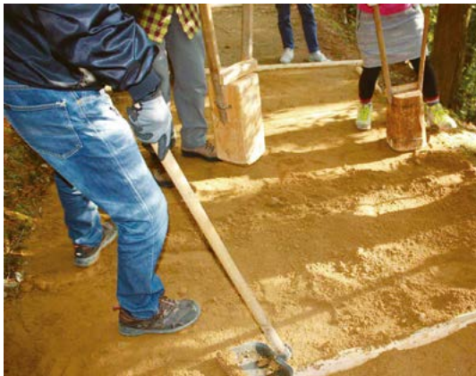
タコでたたいて固める作業の様子(阪和興業提供)
