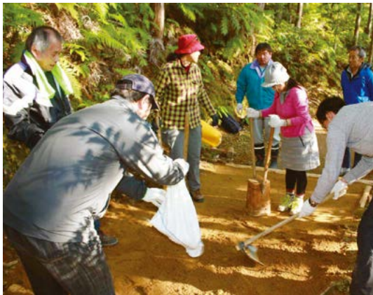
土を運び入れる作業の様子(阪和興業提供)
