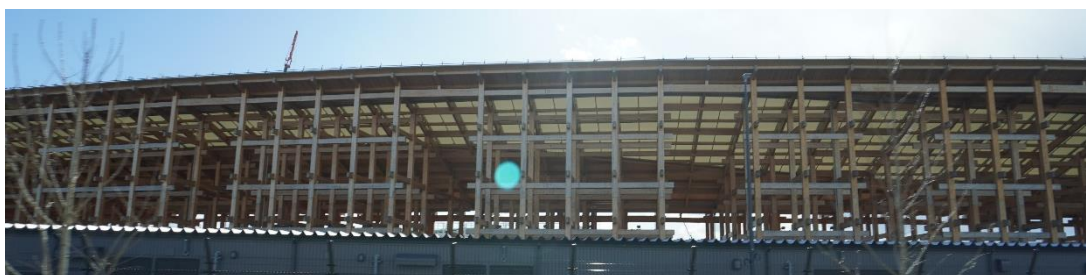
大屋根（リング）近景
