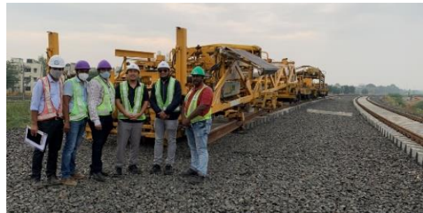
敷設現場(Gujarat州 Surat市北部)
