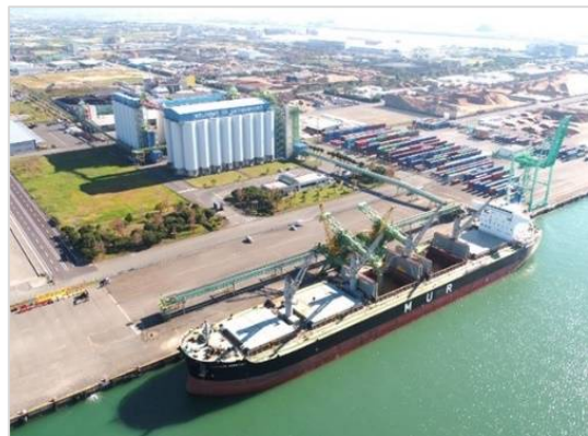
パシフィックグレンセンターの荷役の様子
