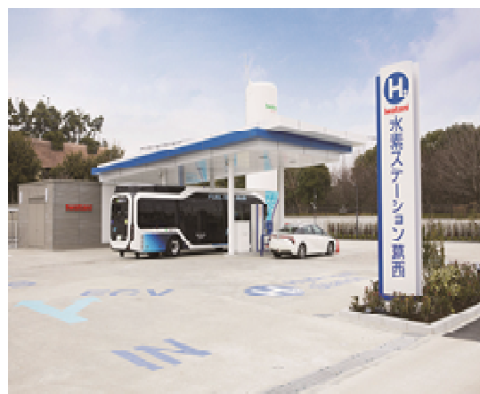
燃料電池バスへの充電が可能 「イワタニ水素ステーション東京葛西」
